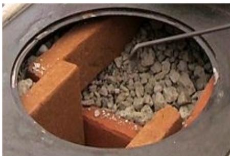
**4. Arena y tierra:** (libre de material orgánico) será como material aislante de la temperatura para proteger la estructura de concreto.
